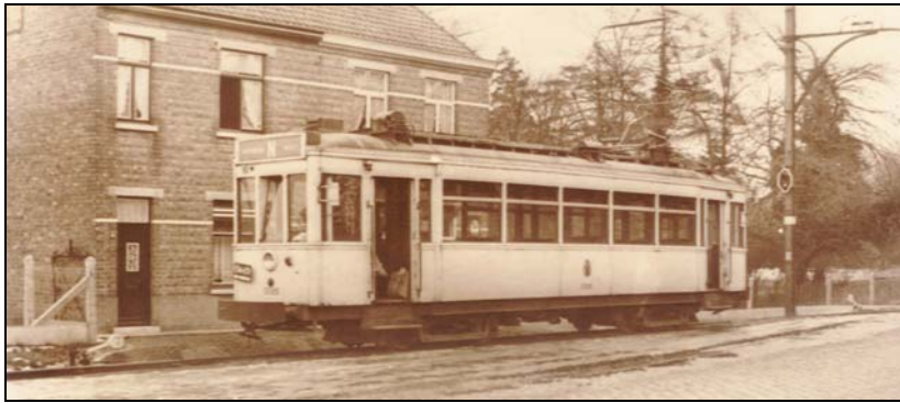
Een elektrische tram tussen de Wagenbrug en de Stelplaats aan café 'In de Wachtzaal bij Maria'.
