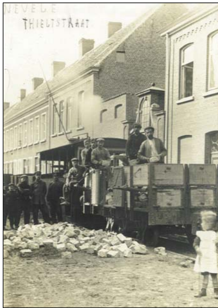
Herstellingswerken aan de tramlijn in de Tielstraat (nu Cyriel Buyssestraat) in 1922.
